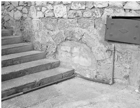
Fig. 5 Castro, zona Pilulaccu , part. dell'arco di un'antica condotta d'acqua.
