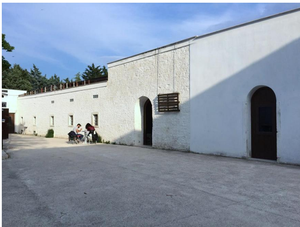
Fig. 4 – MAT: facciata laterale dello stabile principale
