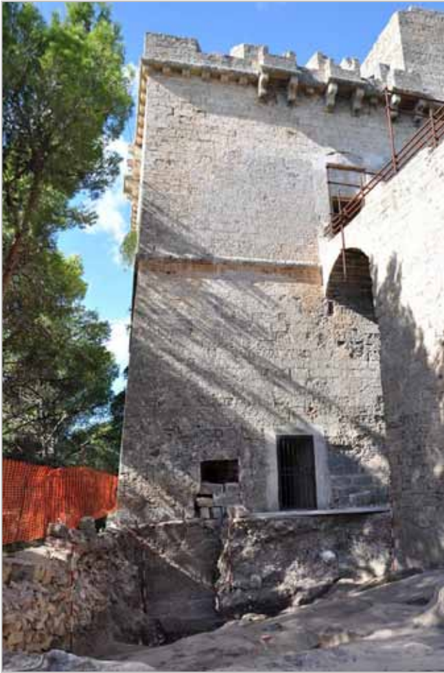
Fig. 1. Veduta della Torre Santa Caterina al termine del restauro architettonico.
